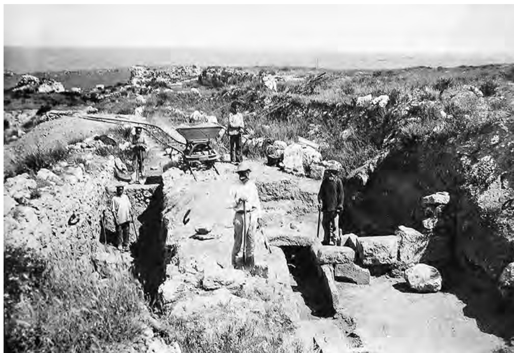
Раскопки участка оборонительной стены в западной части Херсонеса (Моисеев 1918: рис. 93)
