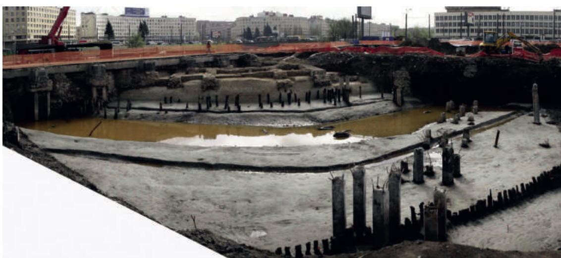
Рис. 4. Ниеншанц. Конструктивное устройство крепостного рва, общий вид со стороны юго-восточной куртины: первая линия частокола, канава второй линии, кювет
